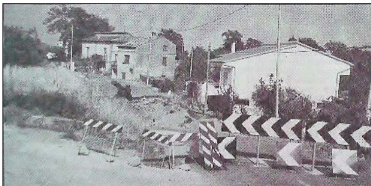
Fig. 63: La frana che interrompe la SS 105 da un anno (R44/1997)
