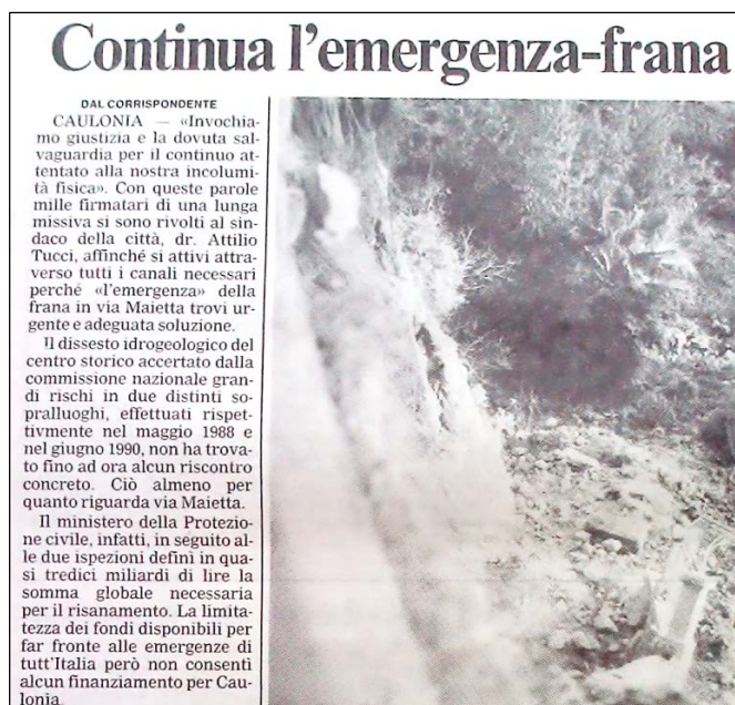
Fig. 25: La frana che interessa piazza Carmine a Caulonia (R73/1993)
