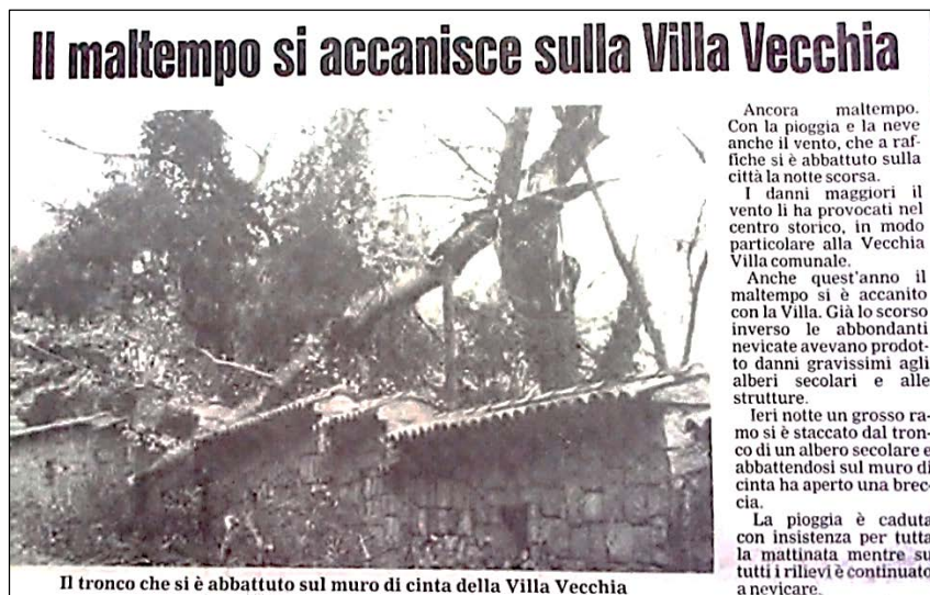
Fig. 14: Muro della Villa Vecchia danneggiato dal crollo di un albero secolare (R63/1991)
