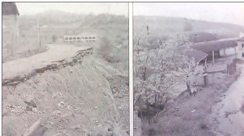
Fig. 62: Contrada Battipetto; a sinistra, la frana sulla SS 509; a destra, i capannoni dell'ex fabbrica di laterizi (R35/1997)
