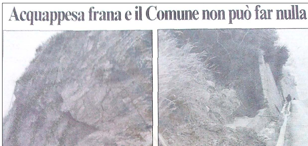
Fig. 15: Alcune zone di Acquappesa interessate dal vasto movimento franoso (R4/1992)
