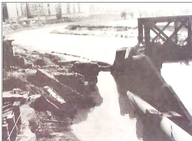
Fig. 53: Il ponte della ferrovia distrutto dalla piena dell'Esaro (R199/1996)
