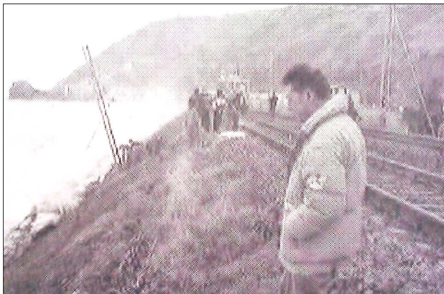
Fig. 83: Il palo dell'elettrificazione della ferrovia asportato dalla mareggiata (R27/1999)
