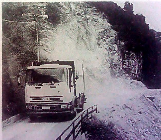
Fig. 60: La frana sulla via Alfieri (R16/1997)
