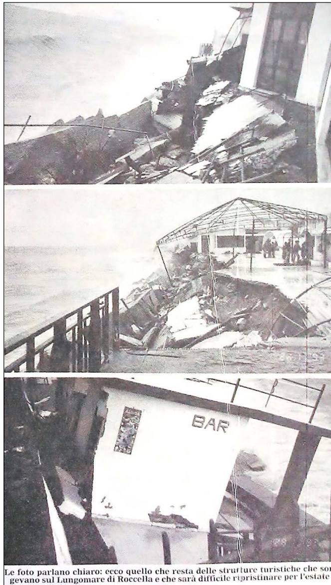
Fig. 28: Strutture turistiche danneggiate dalle mareggiate a Roccella (R99/1993)
