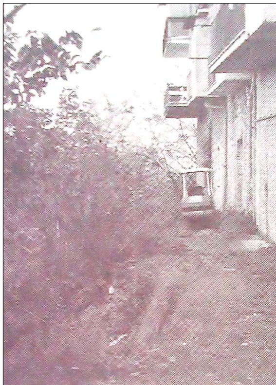
Fig. 100: La frana di via Sicilia, a ridosso delle abitazioni (R139/1999)
