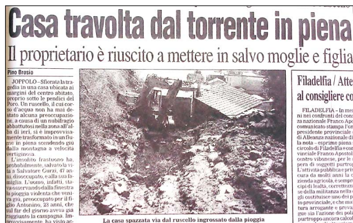
Fig. 92: La casa travolta dalla piena improvvisa di un ruscello (R86/1999)
