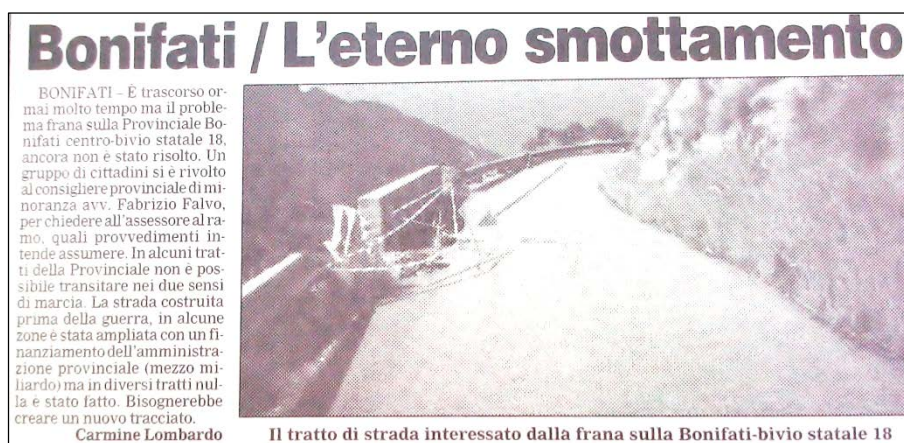
Fig. 76: La frana sulla strada provinciale (R63/1998)
