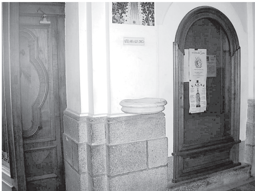
Figura 7. Chiesa Matrice o di S. Biagio (Serra S. Bruno, Catanzaro): la targa apposta sull'acquasantiera indica il livello raggiunto dalle acque del fiume Ancinale durante la piena del 21 novembre 1935 (Foto: O. Petrucci).
